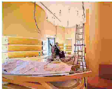
Lavori per l'allestimento del corner
